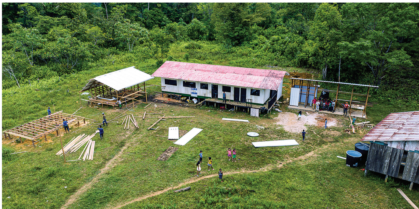
📷 Rénovation d'une école endommagée dans une communauté autochtone en Antioquia, Colombie
