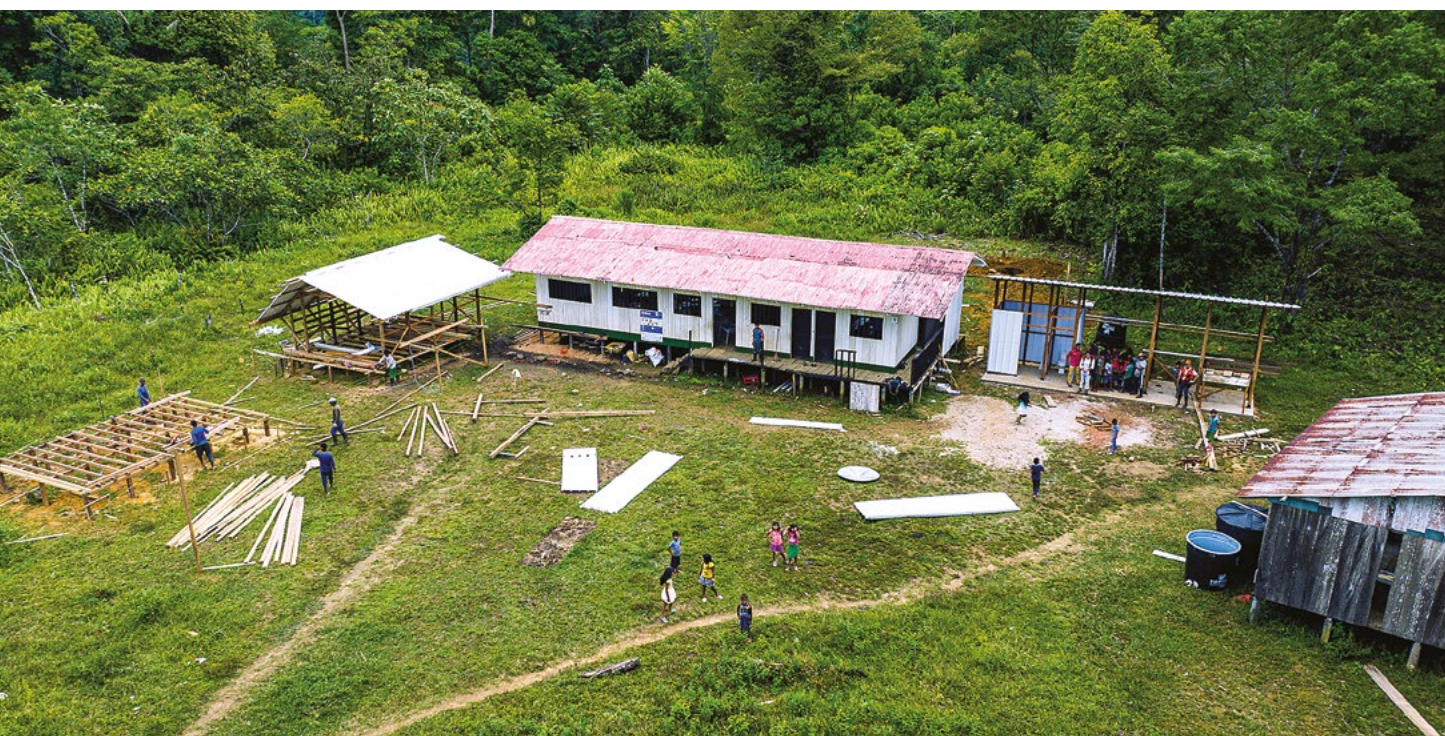
📷 Rénovation d'une école endommagée dans une communauté autochtone en Antioquia, Colombie
